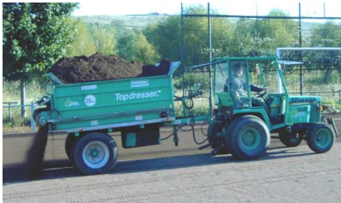
Auftragen des Sandes
